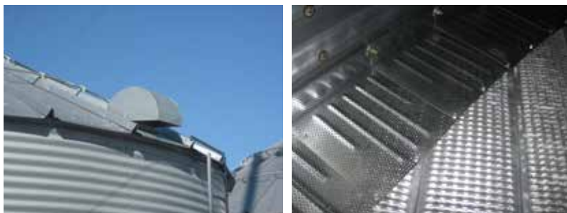
Figure 3.9 Exemple de sortie d'air sur le toit du silo et exemple de plancher perforé
