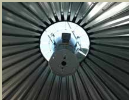
Figure 2.3 Éparpilleur rotatif installé au haut du silo Source : www.brockgrain.com
